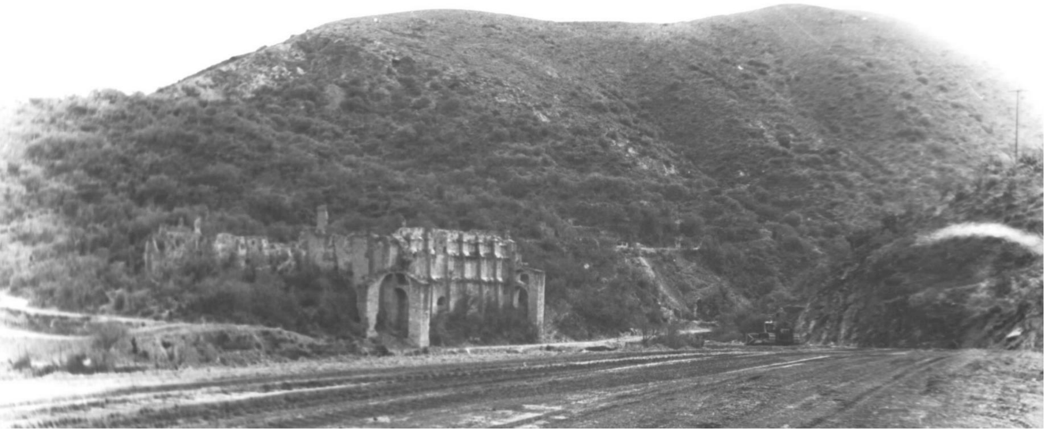
Fotografía 11. Fotografía histórica de la construcción de la carretera panorámica 01, recuperada de Fototeca del Archivo General del Estado URL: http://archivohistorico.guanajuato.gob.mx/bibliotecadigital
